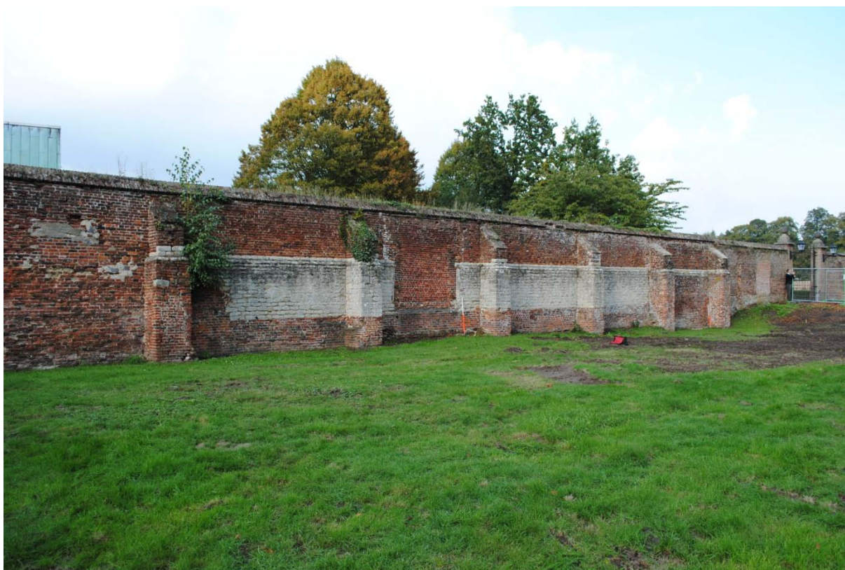
Fig. 10: Zuidzijde van de zuidelijke abdiomwalling met resten van de oude parochiekerk.
