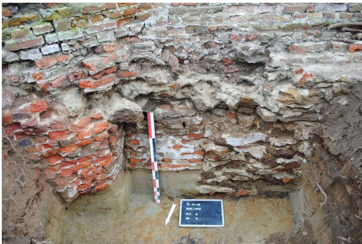
Fig. 15: Zicht op de fundering van muur 39 en apsis 12 in put 6.
