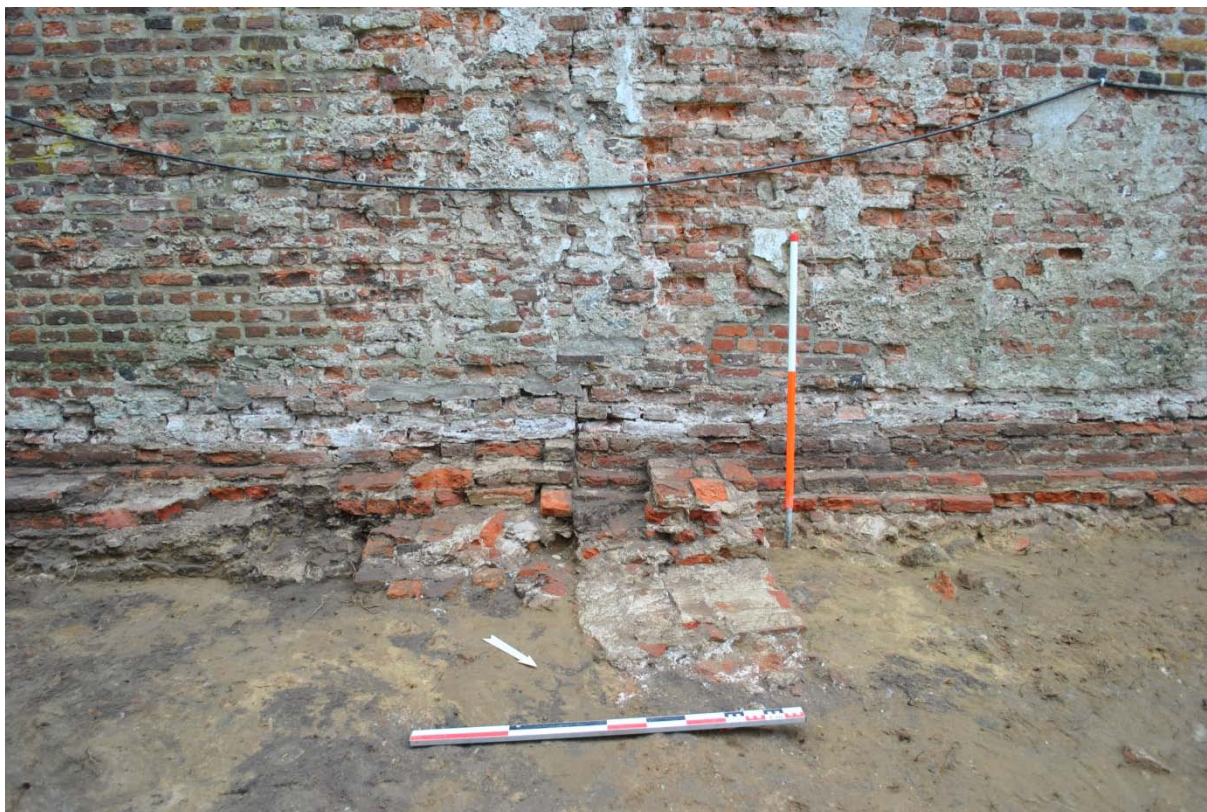
Fig. 12: De fundering van een koormuur (spoor 23), met twee uitbreidingen naar het oosten (sporen 25 en 21).
