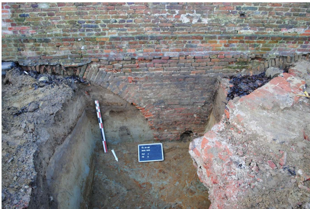
Fig. 17: Zicht op de spaarbogen in put 7.
