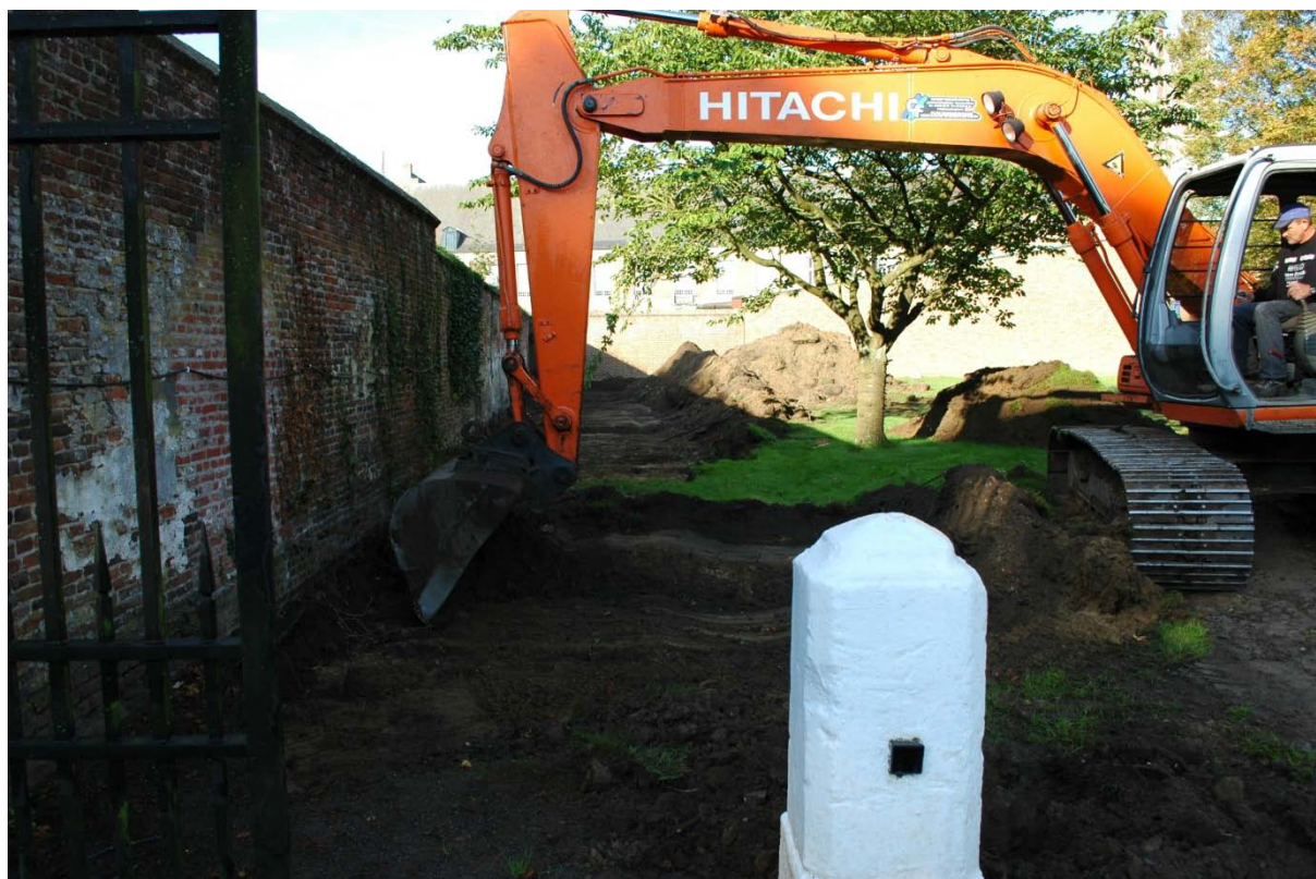
Fig. 8: De aanleg van het vlak.
