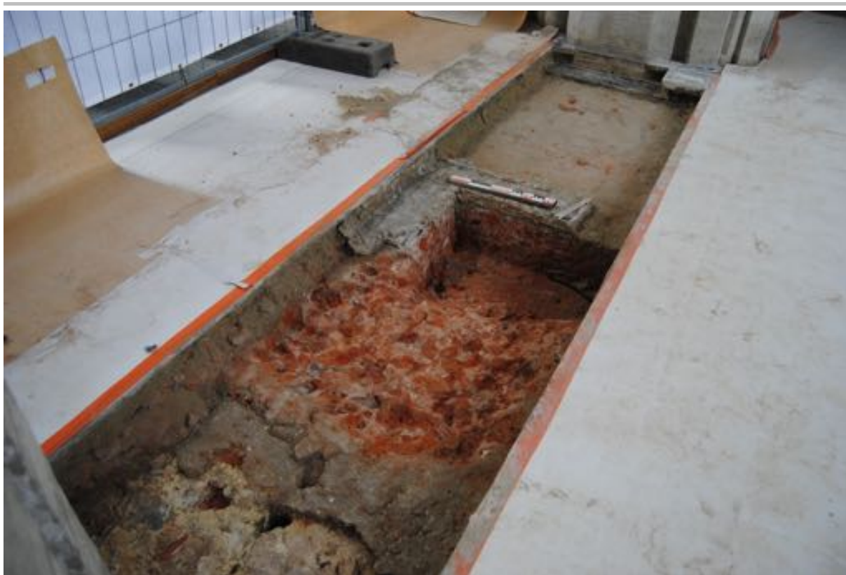
Fig. 4.16: De massieve fundering in cementmortel en baksteenbrokken (S 9) in werkput 3.
