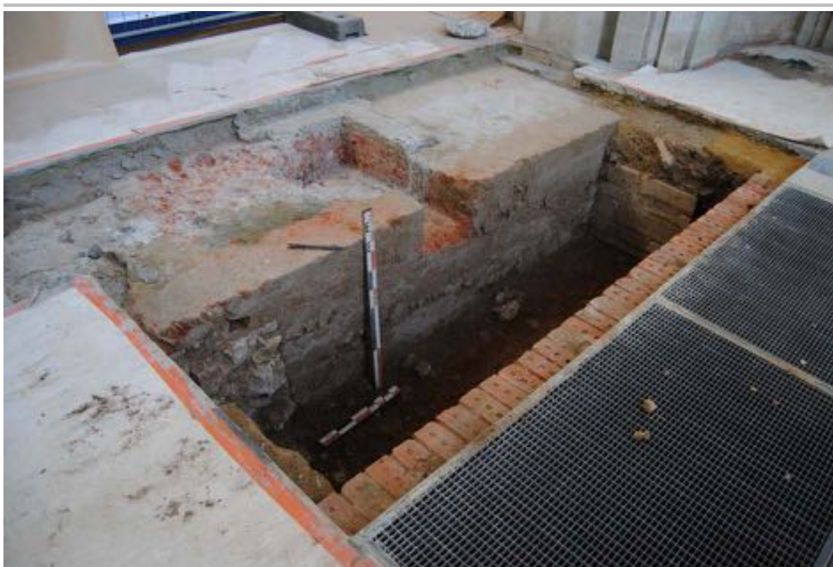
Fig. 4.19: De betonnen fundering in werkput 9, met de twee stratigrafisch oudere structuren (S 22 vooraan en S 21 achteraan).
