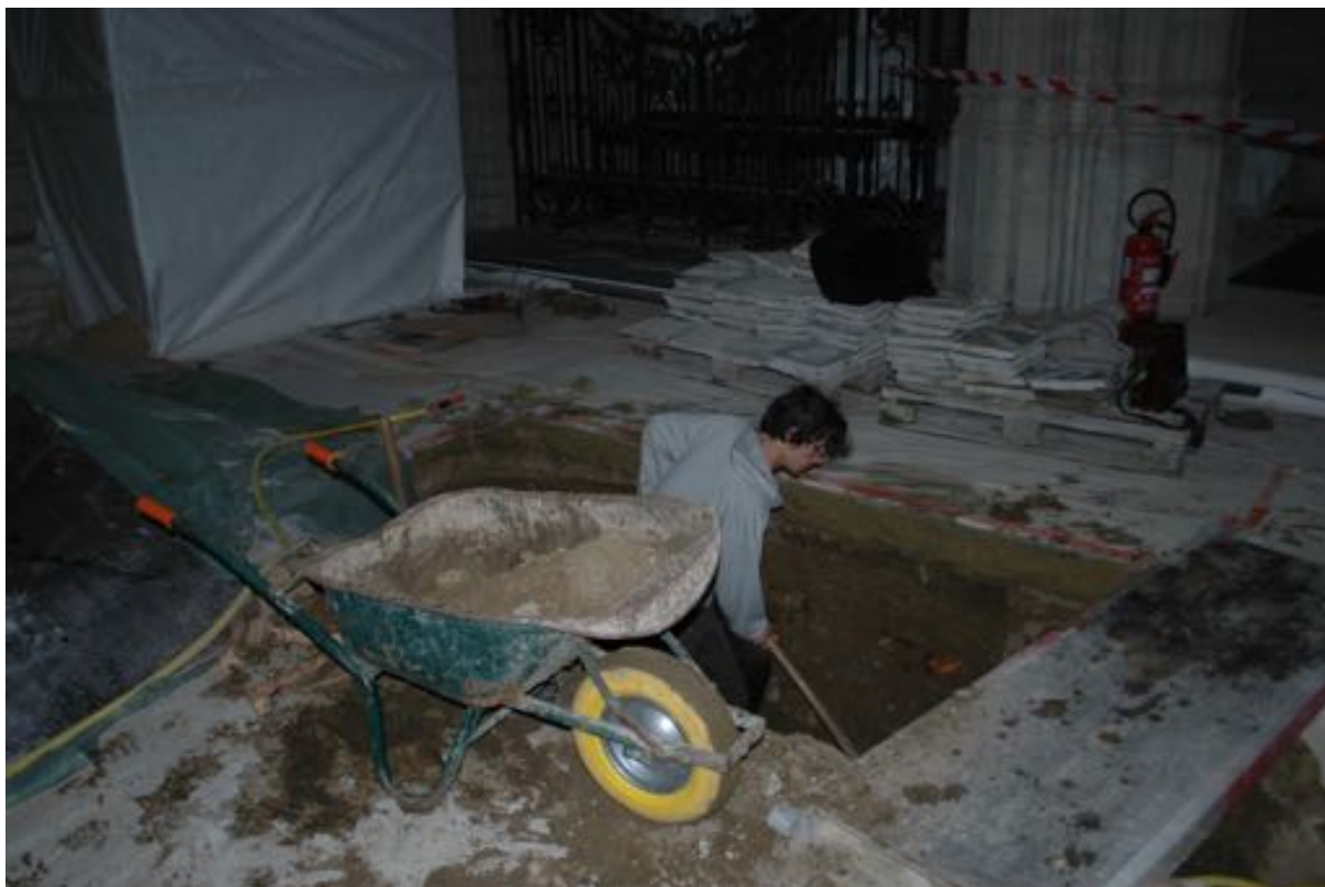
Fig. 3.2: Het manueel uitgraven van de sleuven.
