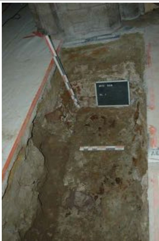
Fig. 4.8: De eerder noordzuidgeoriënteerde muur (S 3) die stratigrafisch recenter is dan de oostwestgeoriënteerde (S 2) in WP 1.
