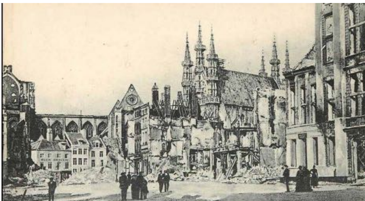
Fig. 2.2: De beschadigingen aan de kerk en de omgeving na de brand van 1914 29 .
