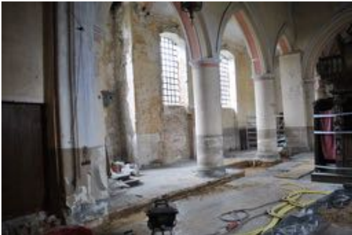
Fig. 2.1: De uitgraving in het zuiden van het schip.
